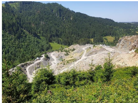
Abbildung 13: Blick von Nordosten auf den Steinbruch
