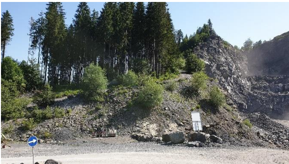
Abbildung 10: westliche Abbaukante und Petratschwodweg
