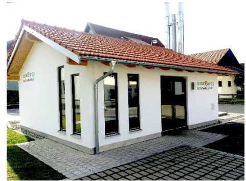
Heizzentrale Marktwärme Wertach I
