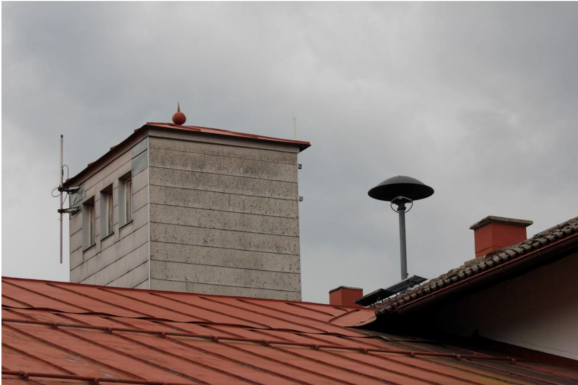
Abbildung 7: Verschalung am Trocknungsturm
