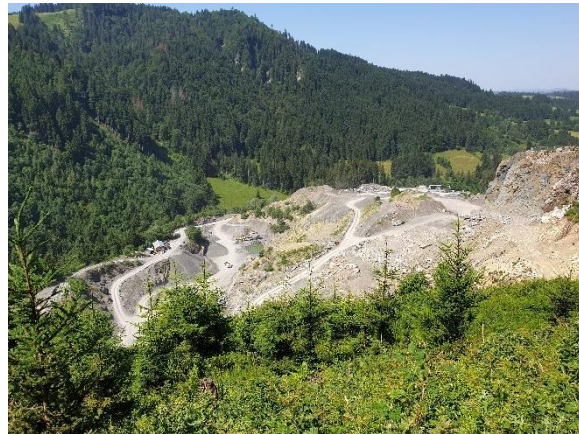
Abbildung 13: Blick von Nordosten auf den Steinbruch
