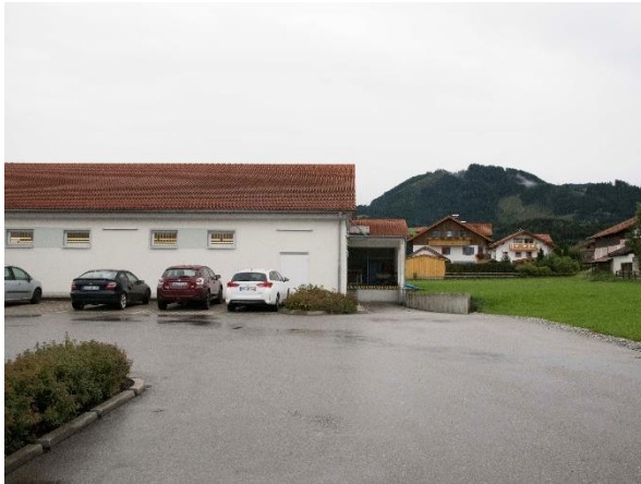
Abbildung 2: Blick von Westen auf den zu erweiternden Gebäudeteil des Lebensmittelmarktes
