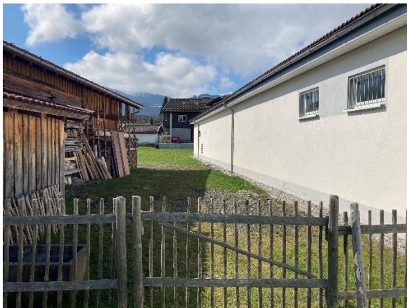
Abbildung 4: Blick von Norden auf die Ostfassade des Lebensmittelmarktes und den Ort der geplanten Einfahrt zu den neu geplanten Mitarbeiterstellplätzen
