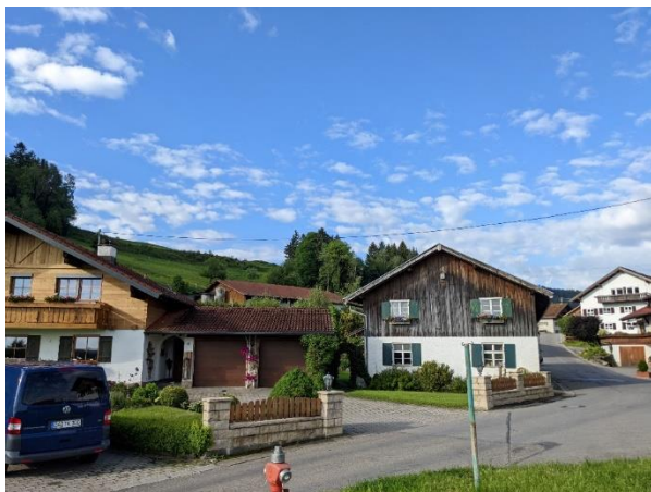
Abbildung 4: Dachformen im Bereich der einzubeziehenden Fläche: Zweigeschossige Wohnhäuser mit angrenzender Garage
