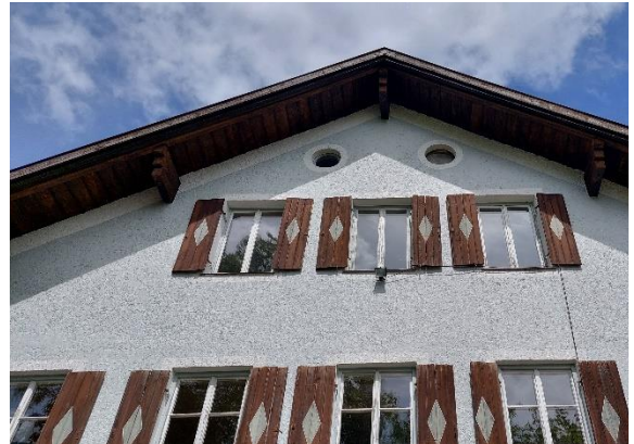
Abbildung 3: Potentielles Einflugloch (rechtes Dachbodenfenster) für Fledermäuse auf der Westseite des Gebäudes
