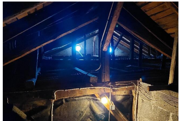
Abbildung 5: Dachbodenbereich im Hauptgebäude
