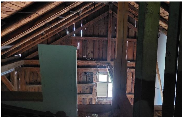
Abbildung 4: Dachbodenbereich im östlichen Anbau
