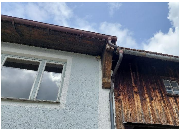
Abbildung 6: Übergang Haupt- zu Nebenbau mit Brutmöglichkeiten für Gebäudebrüter
