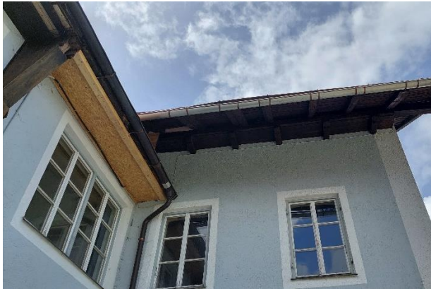
Abbildung 2: Potentielle Einfluglöcher für Fledermäuse auf der Nordseite des Gebäudes
